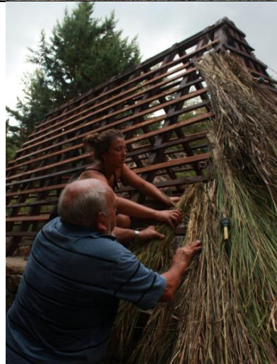
Figuras 7 y 8: Participantes del proyecto construyendo una casa con materiales orgánicos 21
